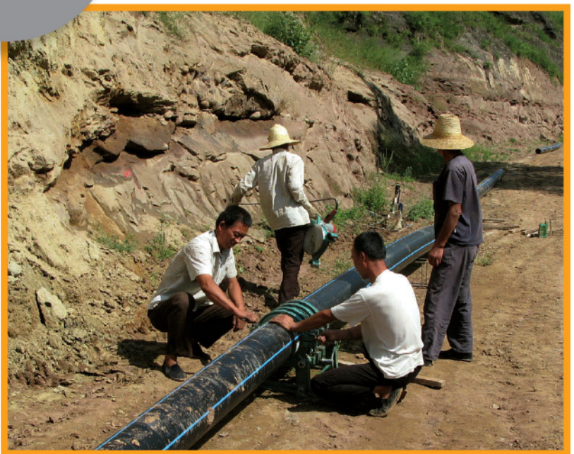
供水工程正在进行主管道施工（陕西省彬县项目办提供）
