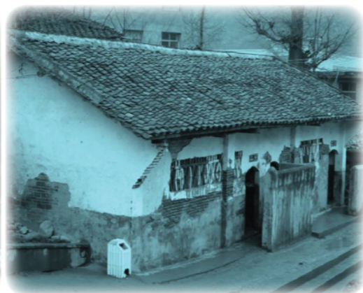
改造前破旧不堪的学校厕所
